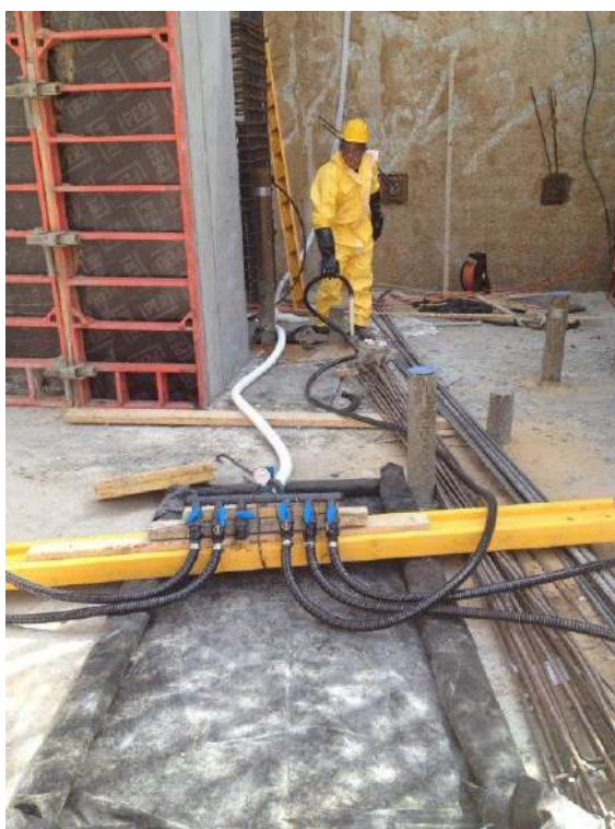
איור 4 : הזרקת חומר המעודד פירוק ביולוגי של Trichloroethylene במגדל אלקטרה (מתחם אמקור לשעבר) בתל אביב.
