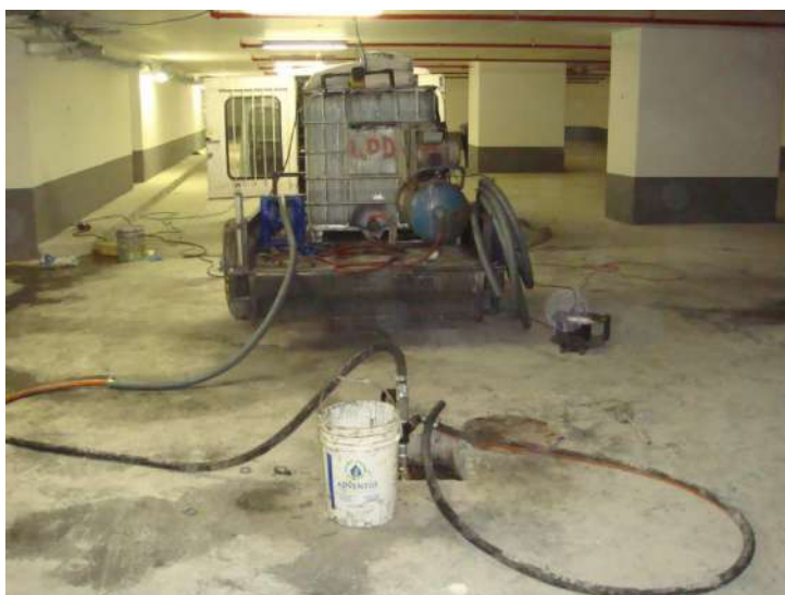
איור 4 : הזרקת חומר המעודד פירוק ביולוגי של Trichloroethylene במגדל אלקטרה (מתחם אמקור לשעבר) בתל אביב.
