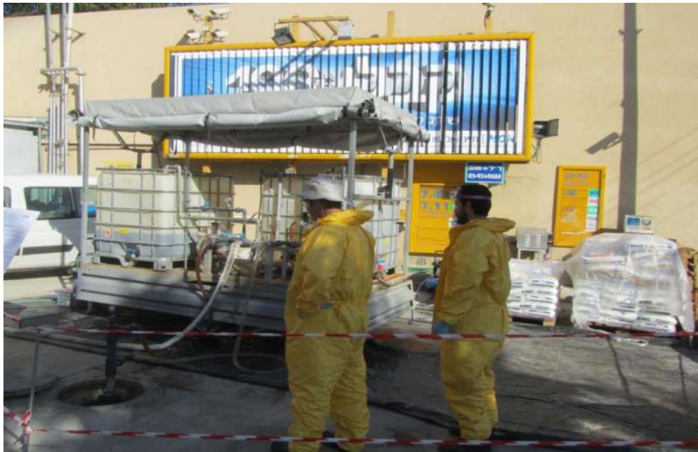
איור 13: הזרקת מחמצן פרסולפט בתחנת דלק להורדת ריכוז MTBE במי התהום
