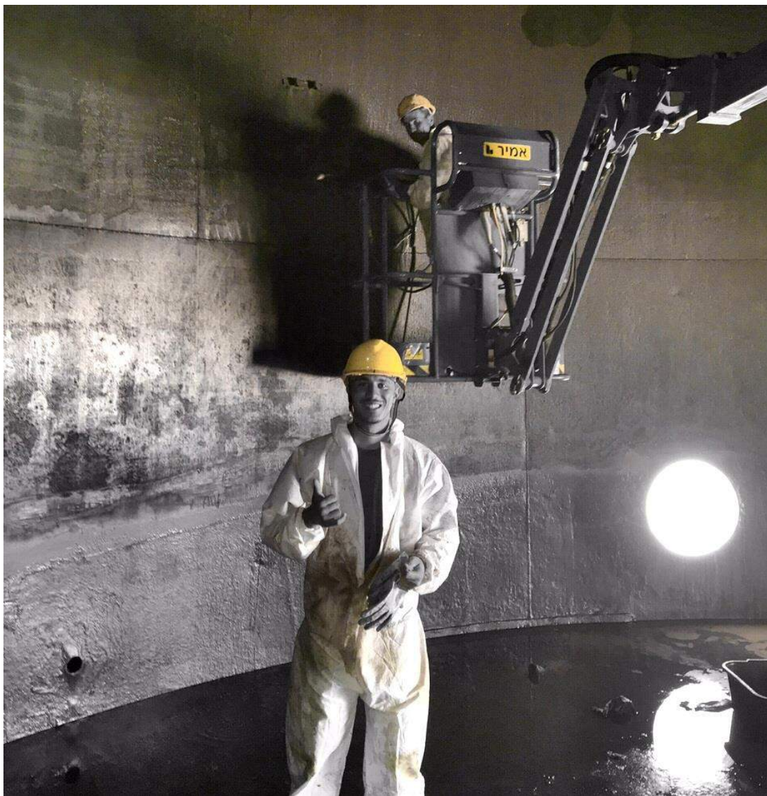
ניקוי מיכל מזוט והבאתו למצב Gas Free
