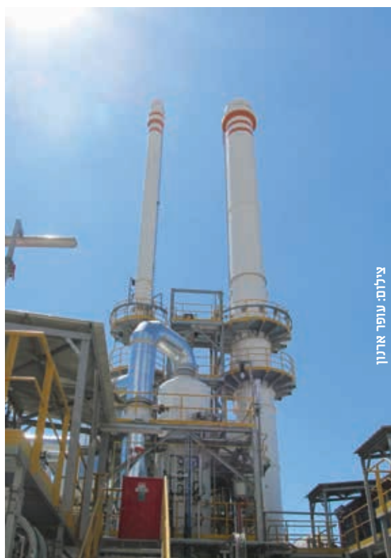
מפעל אדמה אגן באשדוד - מתקן RTO חדש להפחתת פליטות חומרים אורגניים מוכלרים
